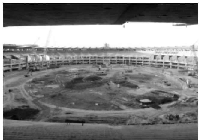
As obras nos estádios seguem em ritmo acelerado para a Copa
